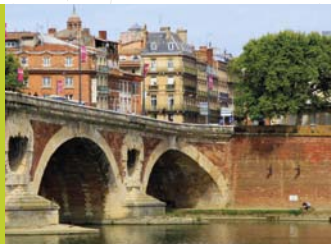
PONT NEUF BRIDGE
